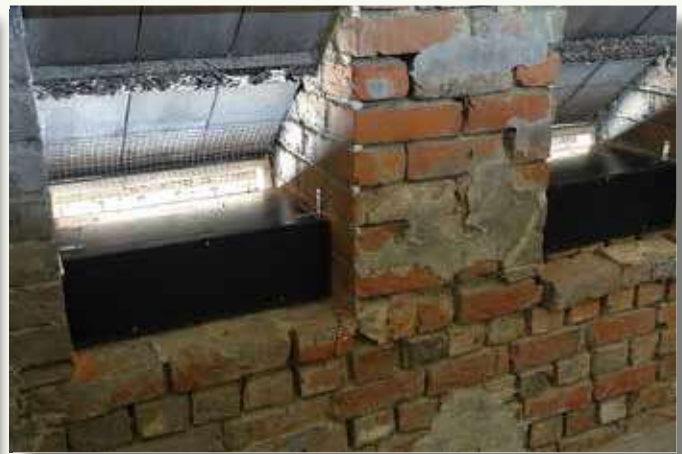
Links: Geert bij het installeren van de bakken in de nissen achter de galmgaten van de kerktoeren. Je kan de invliegopeningen goed zien omdat de achterpanelen nog ontbreken. Rechts: de afgewerkte bakken, klaar voor gebruik. Gierzwaluwen zijn trouwens ongelooflijk propere beestjes. Ook na 20 jaar broeden kan je, zonder schoonmaken, van de grond eten in zo'n nestkast.
