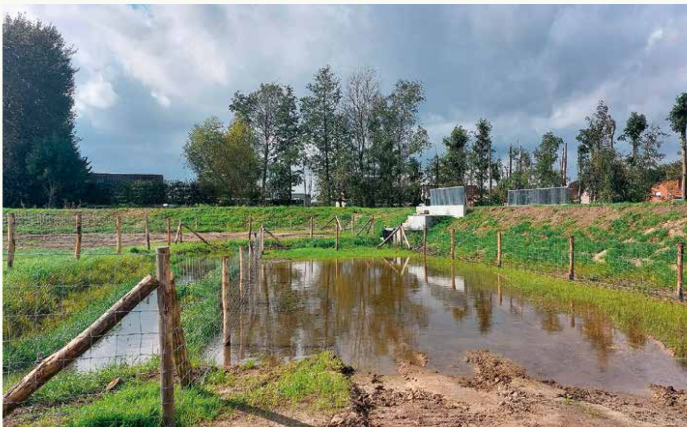
Zicht op de dijk en het sluizensysteem bij de Blekerijbeek in Ichtegem. Indien nodig kan hier 34.000 kubieke meter water vastgehouden worden.
