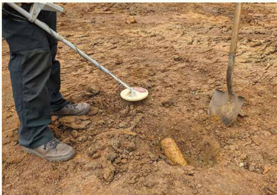
Johan en Rik van ABAF vzw deden zinnig werk met hun metaaldetector: zo'n obus wil je niet raken met de graafmachine.
