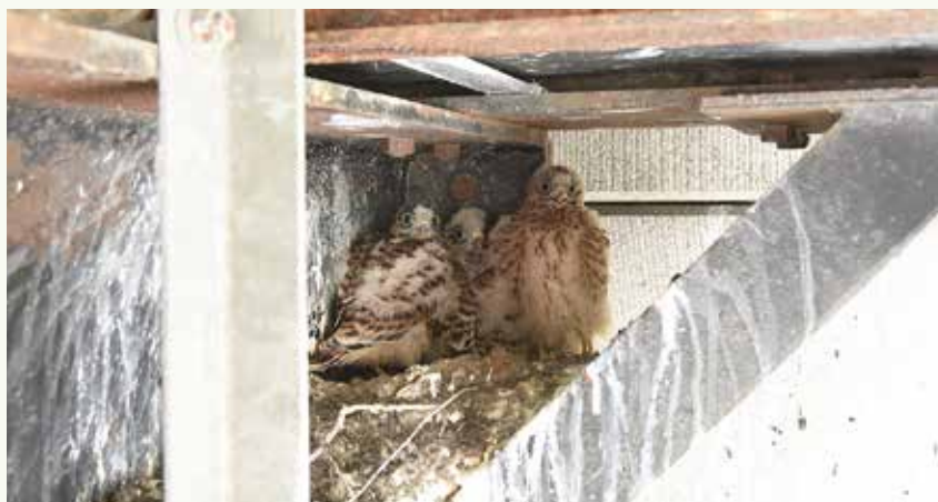
Een torenvalk bracht 4 jongen groot in het stalen gebinte van een industrielloods.
