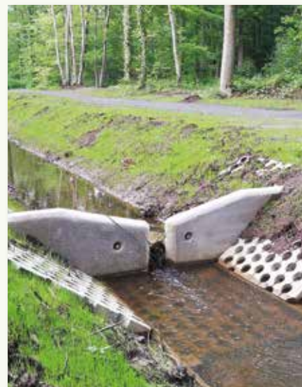
Een knijpconstructie in het Groenhovebos in Torhout.
