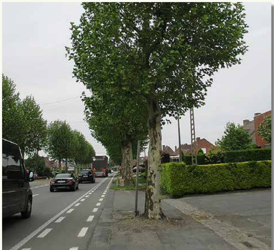
Op deze foto uit het aanvraagdossier is te zien hoe er asfalt tot tegen de boom werd gegoten, maar schade aan het fietspad is niet te zien.
