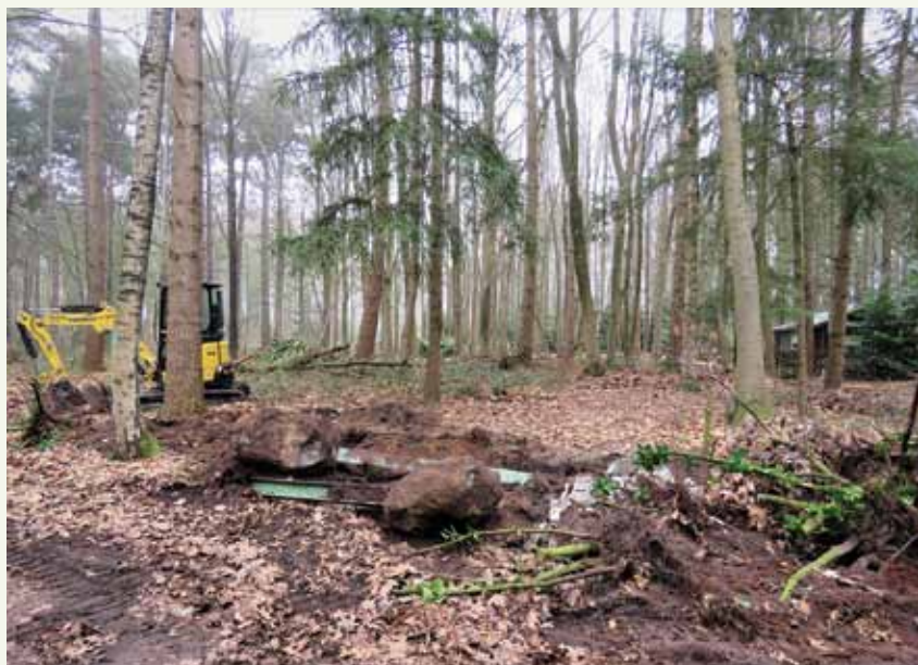
Dankzij de hulp van de graafmachine met kraanman van de stad hebben we heel wat wortelkluiten van laurierkers én enkele onnoemelijk zware betonpalen kunnen verwijderen. Zo wordt het Groenhovebos weer een stukje natuurlijker. Foto: Jozef Germonprez.
