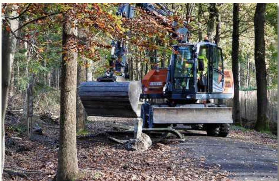
Met de hulp van de kraanman van Natuurpunt en van de stad konden we grote hoeveelheden beton en wortels uitgraven en afvoeren. Nogmaals bedankt voor al die hulp!
