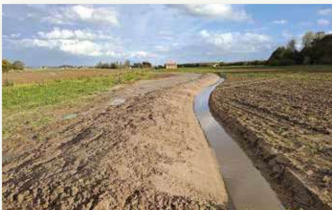
Links een 'swale': deze ondiepe greppel volgt de hoogtelijnen, wat helpt om regenwater te verzamelen, vast te houden en te laten infiltreren in de bodem. Rechts: een vuursteenkling, een van de vele neolithische vondsten die in dit gebied al gedaan werden. Foto's: Koen Maertens.
