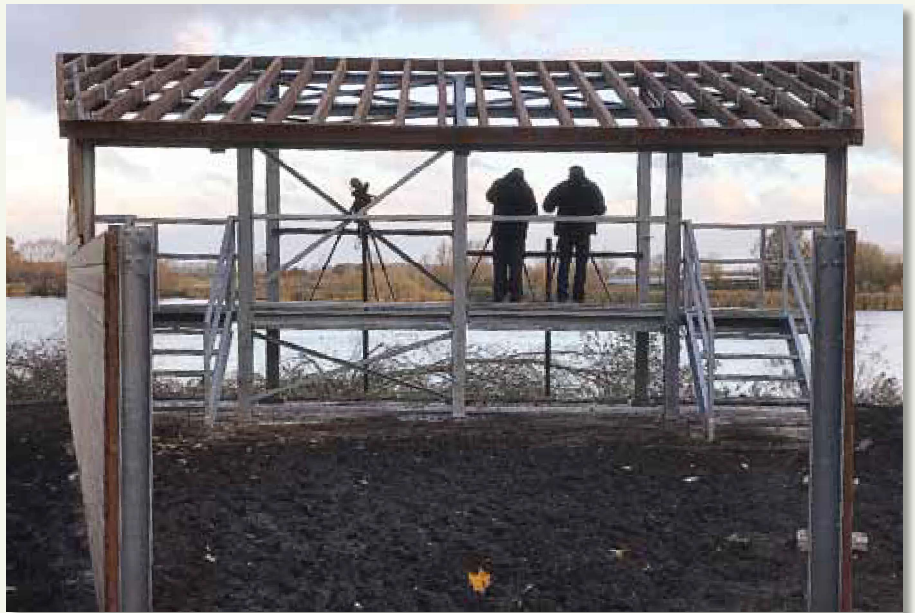
De nieuwe schuilhut in aanbouw wordt al gretig gebruikt.
