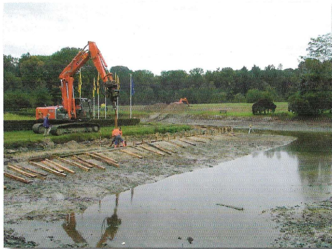
Gebaggerde kasteelvijver en plaatsen van de eikenhouten beschoeiing
